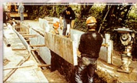
Un système de blindage léger et maniable Une unité, hauteur 0,50 m, est manuable par deux personnes
