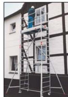
**Hauteur totale : 4,80 m    Hauteur plate-forme maximale : 3,80 m    Hauteur de travail max. : 5,80 m**
